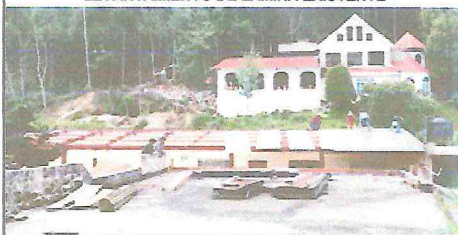
Foto 2: levantamiento de lamina existente modulo No. 2
