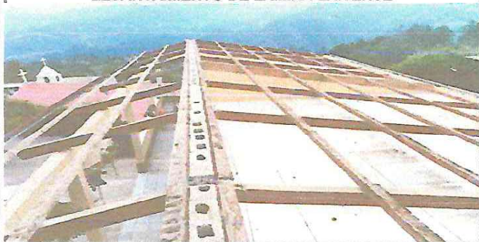
Foto 1: levantamiento de lamina existente en modulo No. 1
