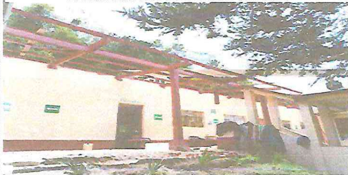
Foto 3: Estructura de edificio numero 2, listo para colocacion de lamina troquelada
