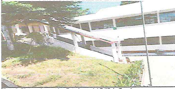
Foto 6: Pintura de paredes Exteriores del Edificio Escolar.
